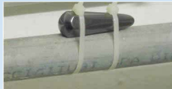
Монтира се върху водопроводната тръба
